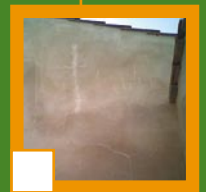
Façonnage des enduits
